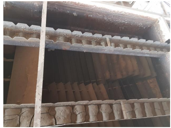
شكل 6: الصفائح المائلة في حوض الترسيب
